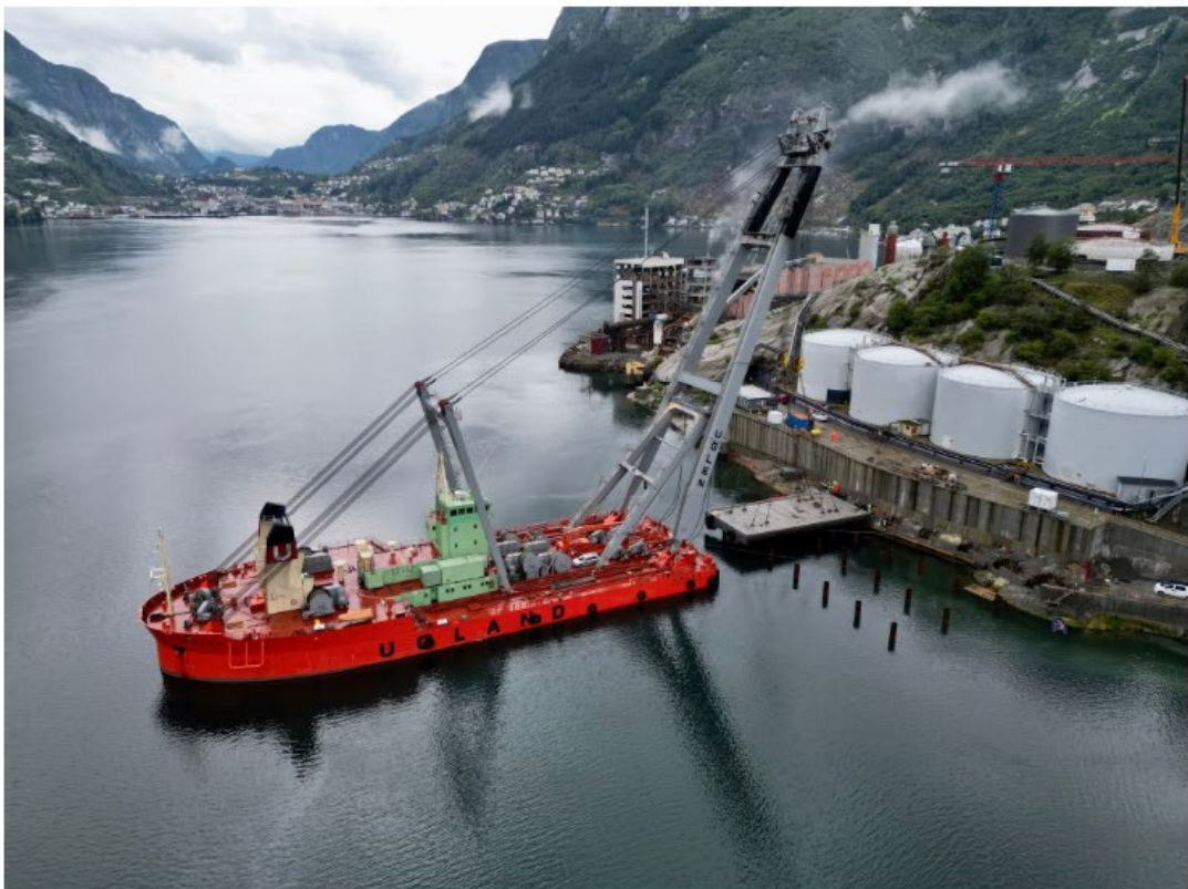
GIGAKRANE: Det er store dimensjonar på kranskipet som vart nytta i arbeidet med å laga ny kai.
